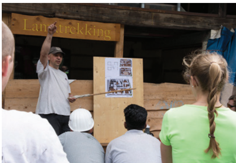
Bergversetzer-Einsatz bei Wohnhaussanierung in Luchsingen / GL
